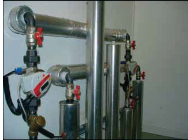
Rys. 1. Czujniki ciepła z interfejsem M-BUS i bramką M-BUS-KNX-Gateway.
