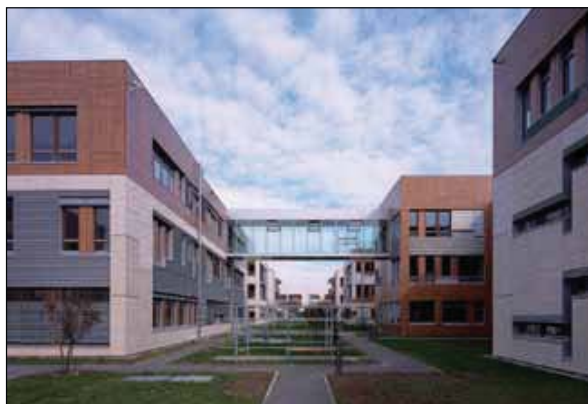
W temacie instalacji oświetlenia pomiędzy kompleksami budynków KNX otwiera potencjał czystej oszczędności energii. Zdjęcie: Infineon/Heinemann
