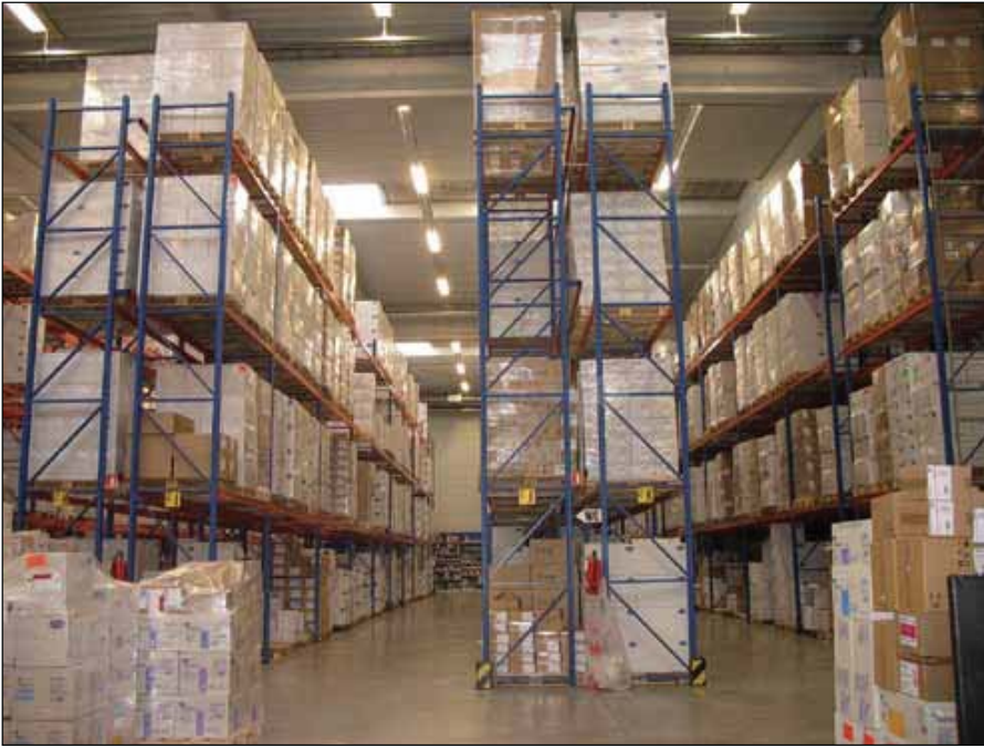
Niższa konsumpcja energii w magazynie związana z automatycznym sterowaniem oświetlenia.
