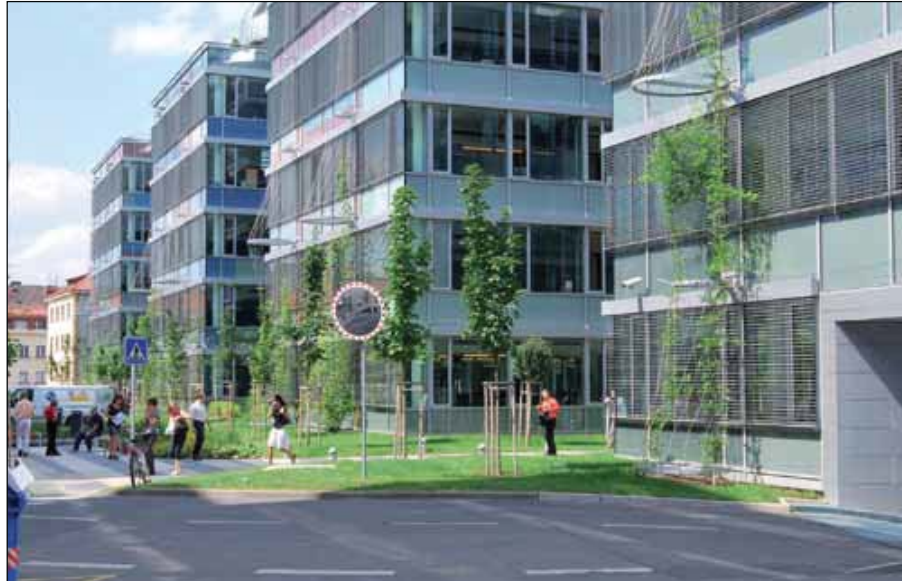
Systemy ochrony przeciwsłonecznej sterowane za pomocą technologii KNX znacząco pomagają polepszyć bilans energetyczny.
